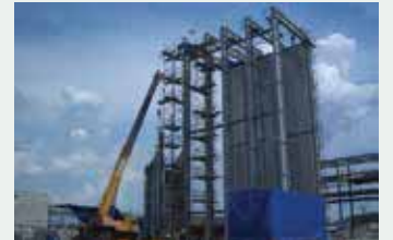
Installation of HRSG Coil
